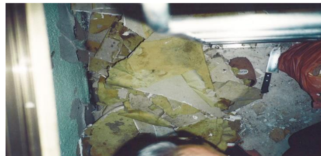
外周壁内部結露の被害状況
