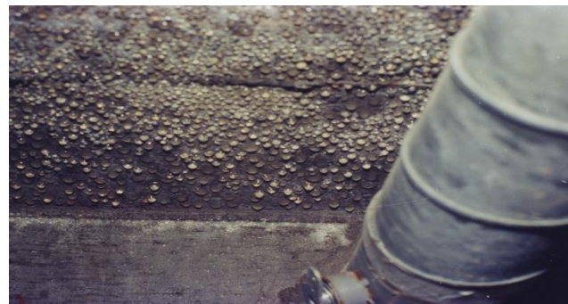
内部結露の被害状況
