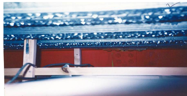
天井裏の金属折板屋根の被害状況
